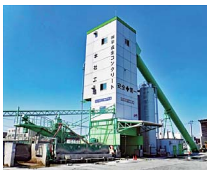
生コンプラント
